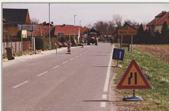
Priprava na preplastitev ceste Mala vas - Muretinci
