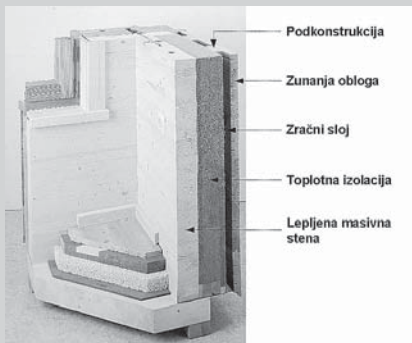
□ Slika 4. Detajl kota Riko hiše s konstrukcijsko sestavo elementov
