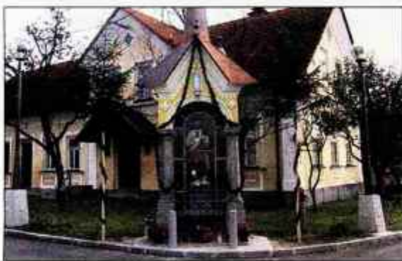
Prenovljena kapelica na Križu
