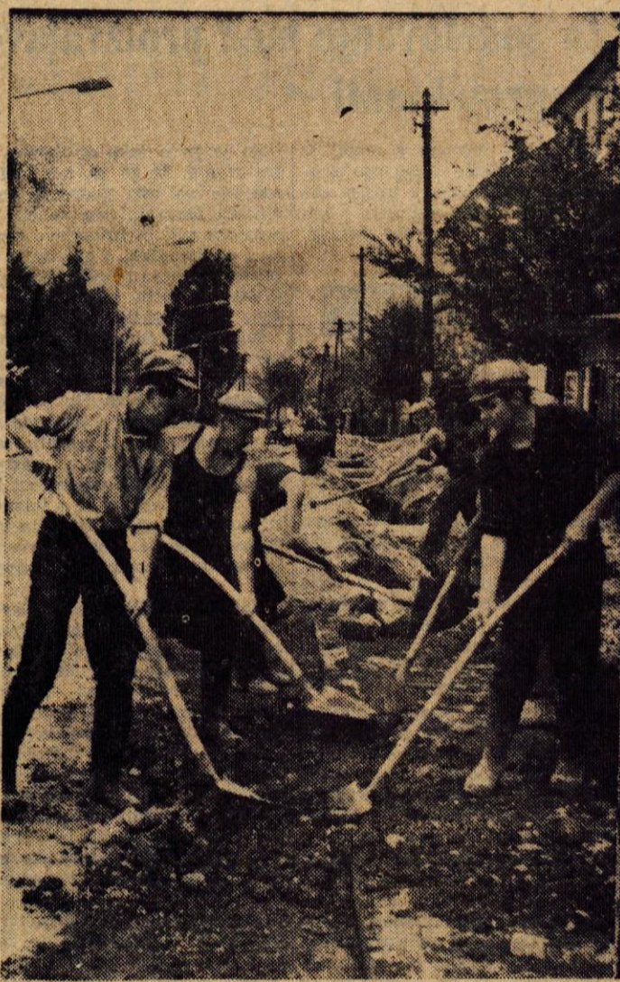
V središču Radovljice so položili nove vodovodne cevi. Stare cevi so bile že zelo slabe. Ker so speljane pod cesto, jih niso izkopavali
