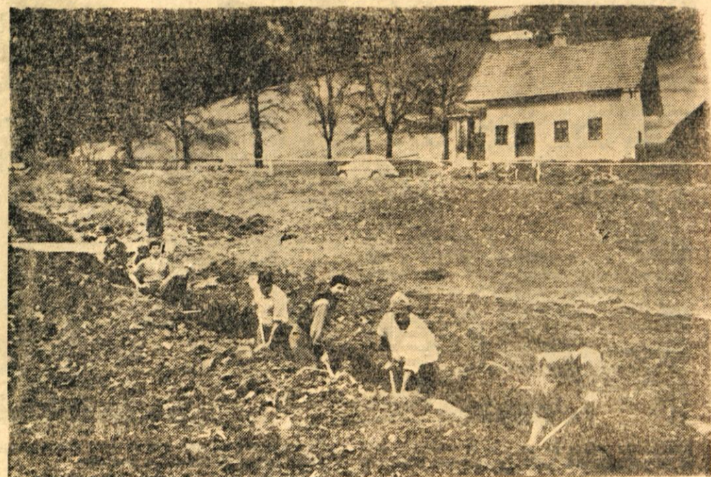
HRUSICA — Vodovod na Hrusicah bo kmalu gotov. Delavci komunalnega podjetja bodo v teh dneh izkopali še zadnje metre jarka za vodovodne cevi, ki jih bodo priključili jeseniškemu vodovodu. Pri gradnji vodovoda na Hrusicah so precej prostovoljno h ur naredili tudi domačini
