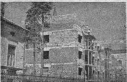
Gradnja stanovanjskega bloka Poslovne zveze.
