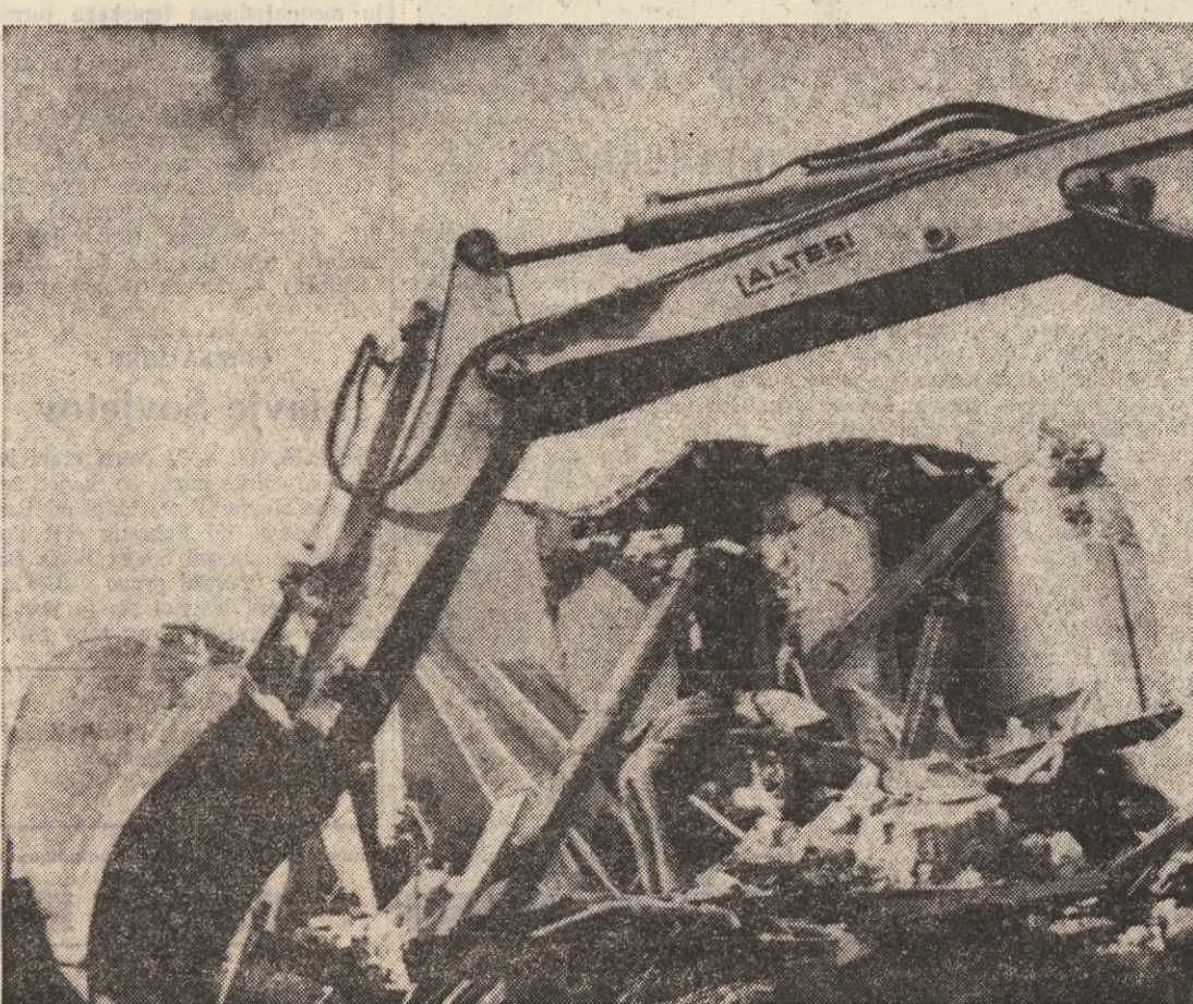
Emblematičen posnetek s potresnega področja: bager ruši to, kar ni zrušil potres, kar je žalostno, a nujno potrebno delo preden se sploh začne z obnovo.
