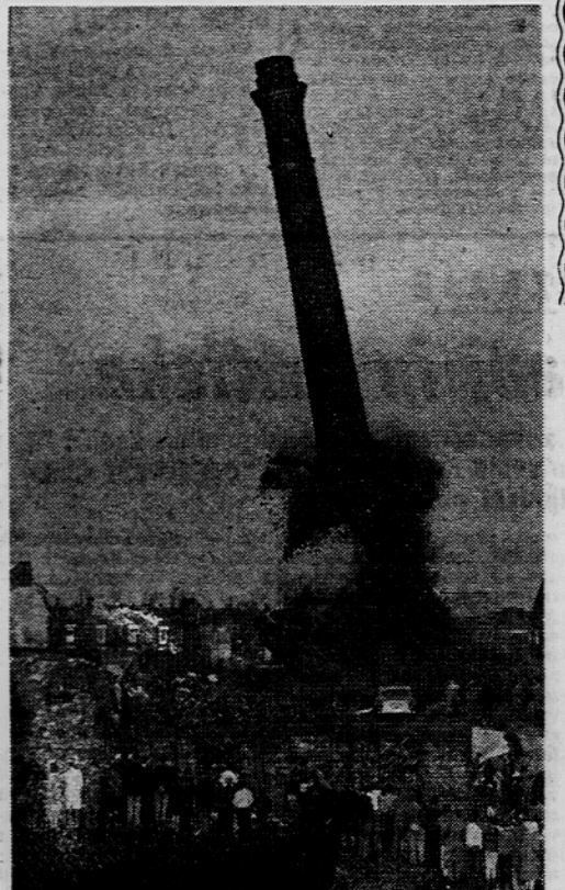
Nekaj trenutkov po eksploziji počasni delujočega razstreliva je zgrmel na tla skoraj 75 m visoki tovarniški dimnik v Boltonu (Anglija). Tovarna se je preselila v nove prostore, nazadnje je bil na vrsti dimnik, ker bodo na tistem kraju sezidali novo stanovanjsko četrt s parkirnim prostorom in s filmsko dvorano. Foto AP
