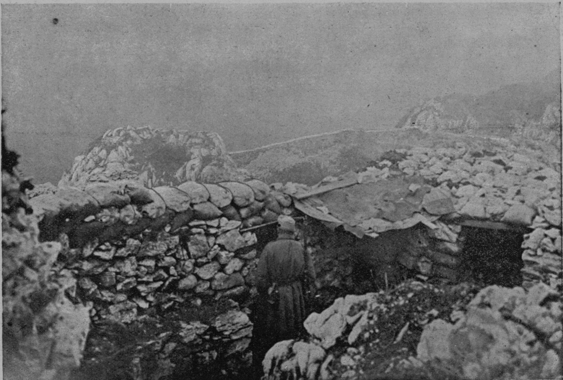
Podzemeljski rovi in kaverne v — — — na Krasu. Vhodi so zgrajeni s kamnja in vreč s peskom.
