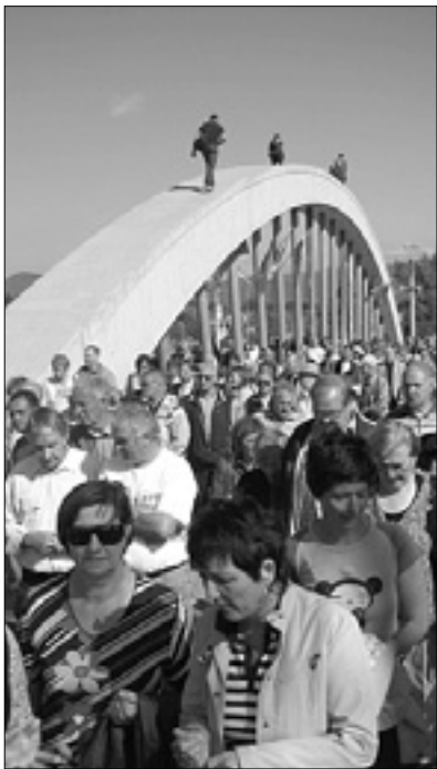
Most nove obvoznice v Renčah FOTO T.B.
