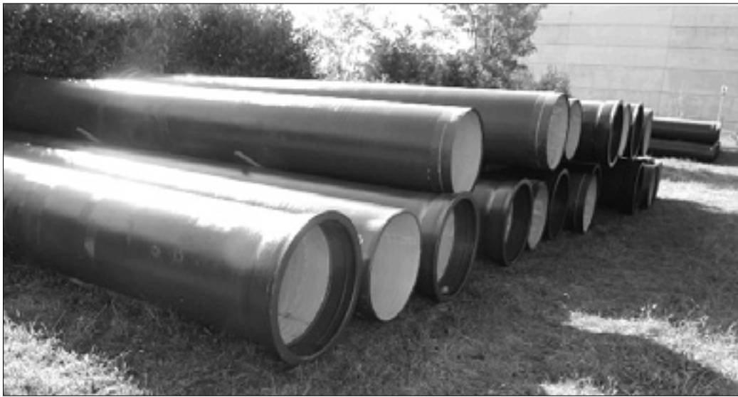
V ulico San Michele so že pripeljali cevi za uresničitev novega grezničnega sistema
