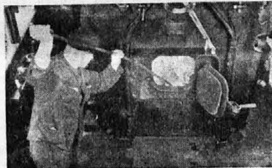
Kurjač z dolgim železnim drogom razmetava žerjavico na rešetki, da bi lepše gorelo.
