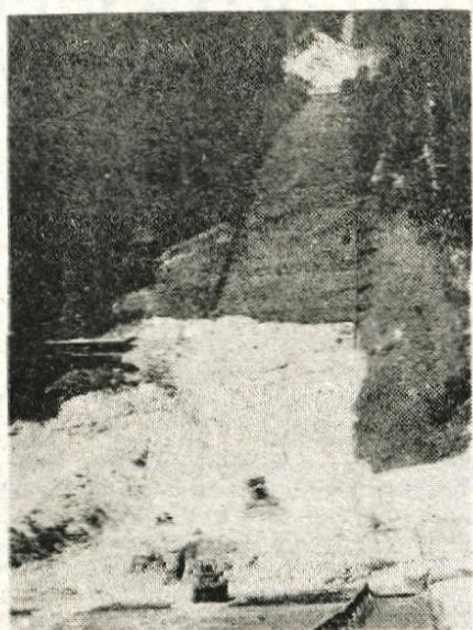
Planica je postala pravo gradbišče... — Foto: D. Sedej
