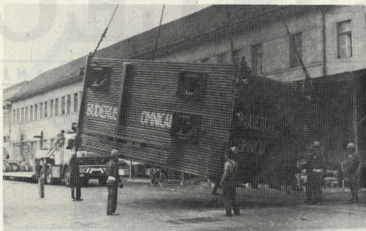
Srednji, najtežji del kotla (23 ton) je dvigalo takole dvignilo s tal
