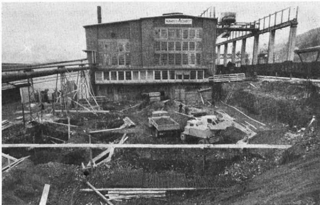
Začeli smo graditi novo kotlaro
