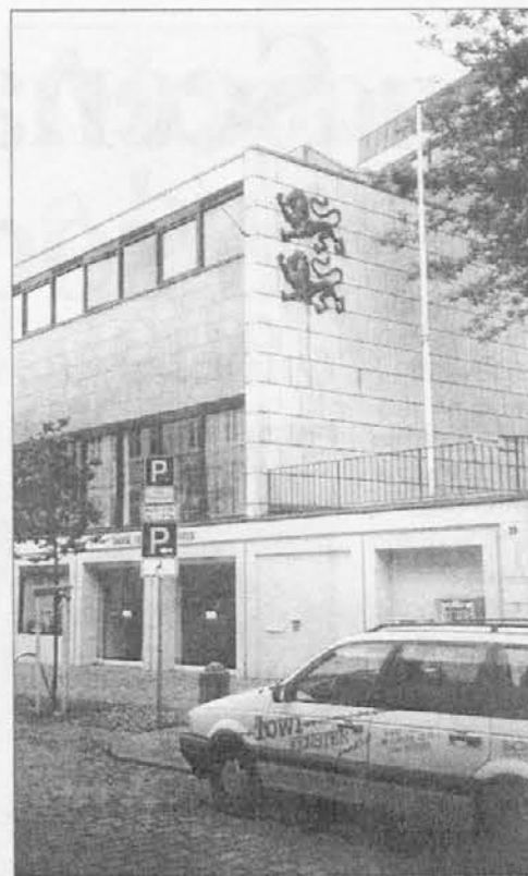
L'ultramoderno edificio della biblioteca con i due leoni, simbolo della minoranza danese
