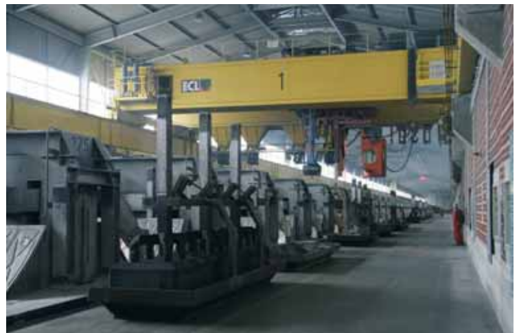
Elektrolizna hala C
