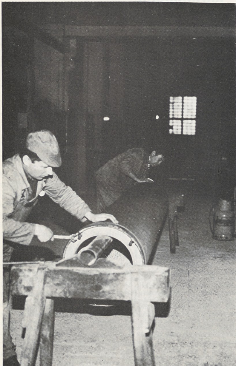
Navlačenje sita na egonter je zahtevno in precizno delo. S tem delom sta dobro seznanjena kleparja — instalaterja Anton Mikelj in Polde Trtnik
