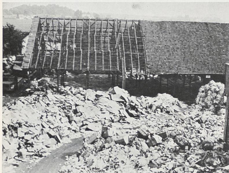
Količevo: Skladišče papirnih odpadkov — lopa 8 je zaradi starosti postalo nevarno za okolico, zato ga je bilo potrebno porušiti (24. 9. 1976)
