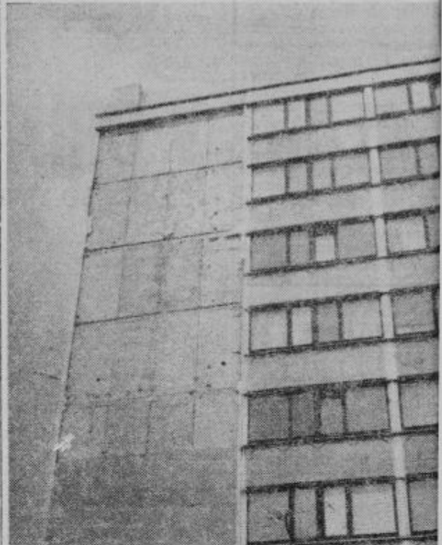
Del fasade bloka, zgrajenega leta 1973. Le slaba štiri leta je fasada zdržala. Grozi podobna nesreča še kje?
