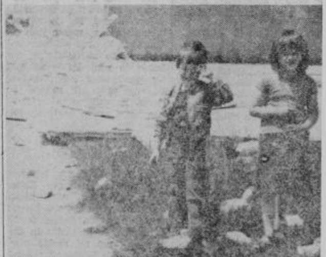
Brezskrbno igra otrok je zmoh hrušč rušičega se stropa in ometa. K sreči je bil poškodovan le en otrok.
