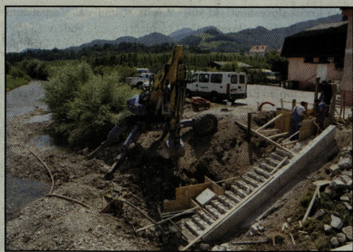
Med izvajanjem gradbenih del pri izdelavi stopnic in za postavitve merilne postaje
