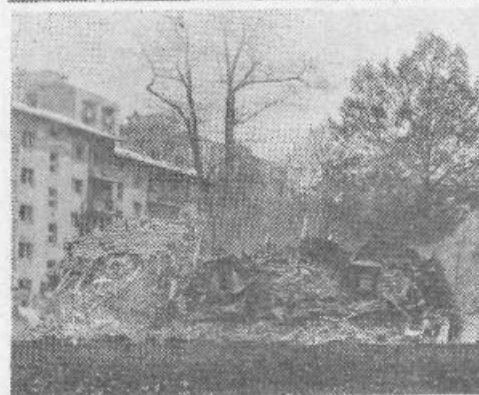
115 let staro zgradbo na Jami, v kateri je domoval Helidona, so v petek, 10. maja, delavci Geološkega zavoda varno porušili. Na fotografiji je zgradba pred, med rušenjem in po njem.
