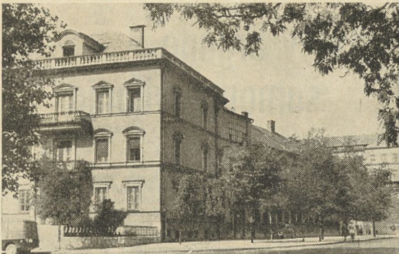
Pogled na upravno poslopje pred nadzidavo ...
