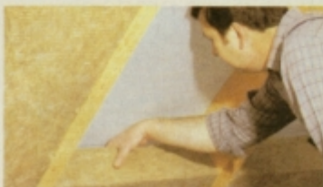
Namestitev toplotne izolacije, ki je različna pri izdelanem podstrežju in neizdelanem podstrežju
