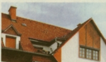
Montaža strelovodov namestitev vseh elementov za strelovode iz Cu, Alu, Fe in Zn ...
