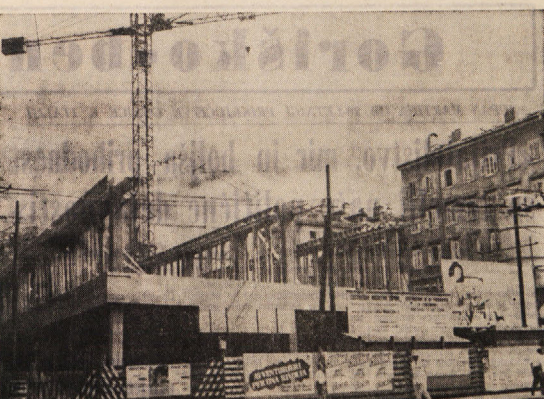
Po zastoji v začetni fazi gradnje, se sedaj na Trgu Stare mitnice precej naglo dviga novo veliko poslopje, v katerem bo imela svoje prostore znana veleblagovnica »Ulima«, v zgornjih prostorih pa bodo tudi prostori za urade in stanovanja. Stavbo gradi podjetje Marcon in Comp. Zgradba bo pridobitev za zunanost tega zelo prometnega trga
