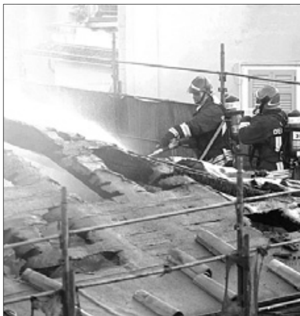
Gasilci na delu v Ulici Mattioli (desno), uničena streha stanovanjskega bloka (spodaj)
