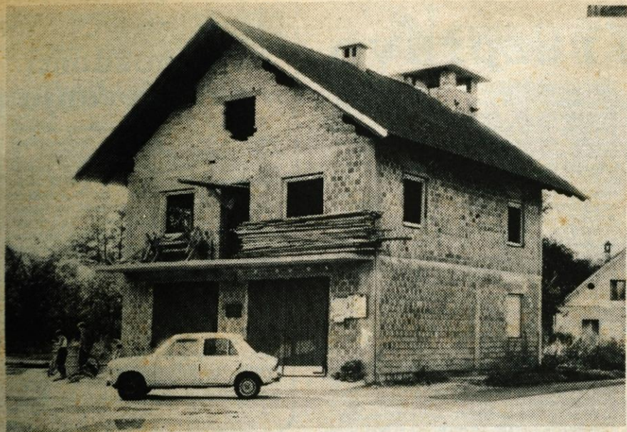
Gasilsko društvo Luče gradi ob nesebični pomoči krajanov nov gasilski dom. Za Luče velja pravilo, da so vsi krajanje gasilci in vsi gasilci najvnetejši zagovorniki napredka vasi
