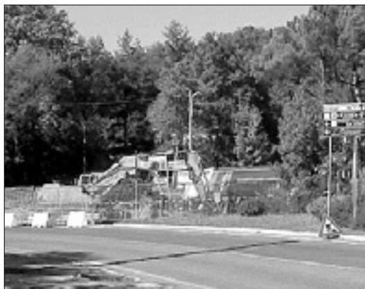
Delovišče pri pevmskem mostu
