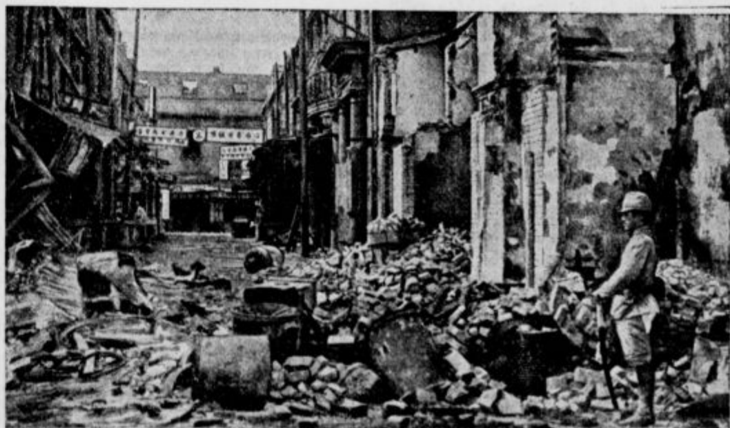
Takšen je zdaj šangajski kolodvor, ko so ga japonski letalci obmetali z bombami.
