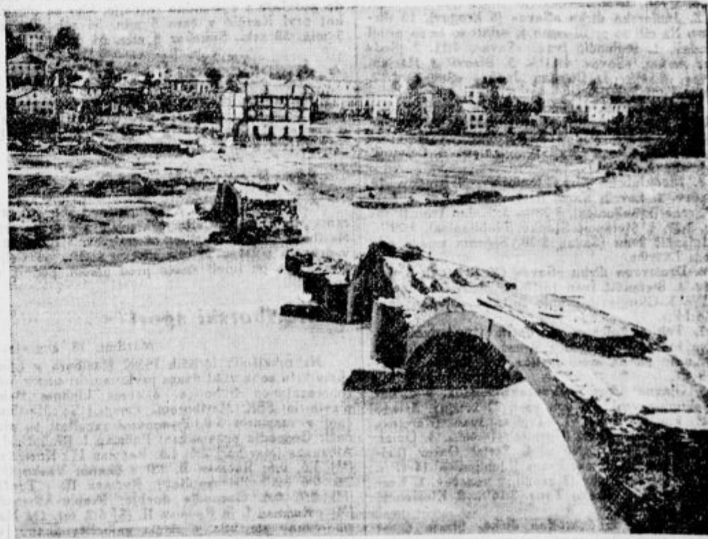
Porušeni most pri Ovadi. Na nasprotni strani so vodne mase tako temeljito porušile hiše, da so ostale samo ruševine in se skoro ne pozna, kje so stale hiše
