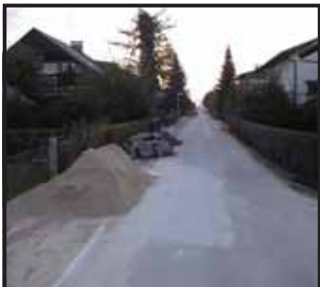
"Na Murnovi se gradi samo plinovod"
