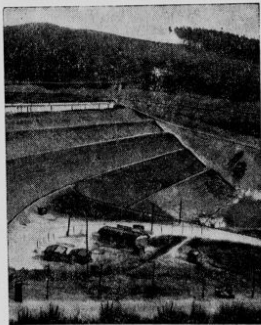
Sösetalska zagradba pri Osterode v Harzu, ki bo oddajala letno 22 milijonov kubičnih metrov pitne vode in je največja tovrstna naprava v Nemčiji.
