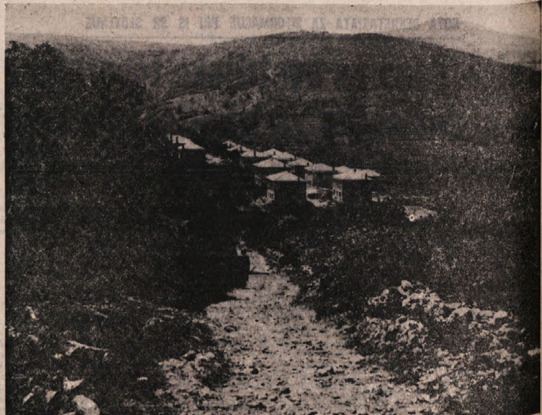
Nova Gabrovica, zgrajena po osvoboditvi na ruševinah in požganih prejšnje
