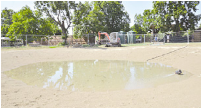
Še zadnja dela v četrtek (zgoraj desno) in prva voda v kalu
