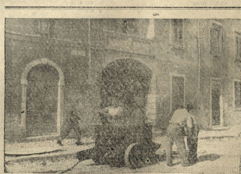
Gli ultimi lavori nella piazza Brollo di Capodistria
