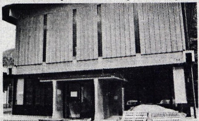
Zunanost tržiške pošte se no bo veliko spremenila, več novosti pa bo v šalterski dvorani. • Foto: S. Saje
