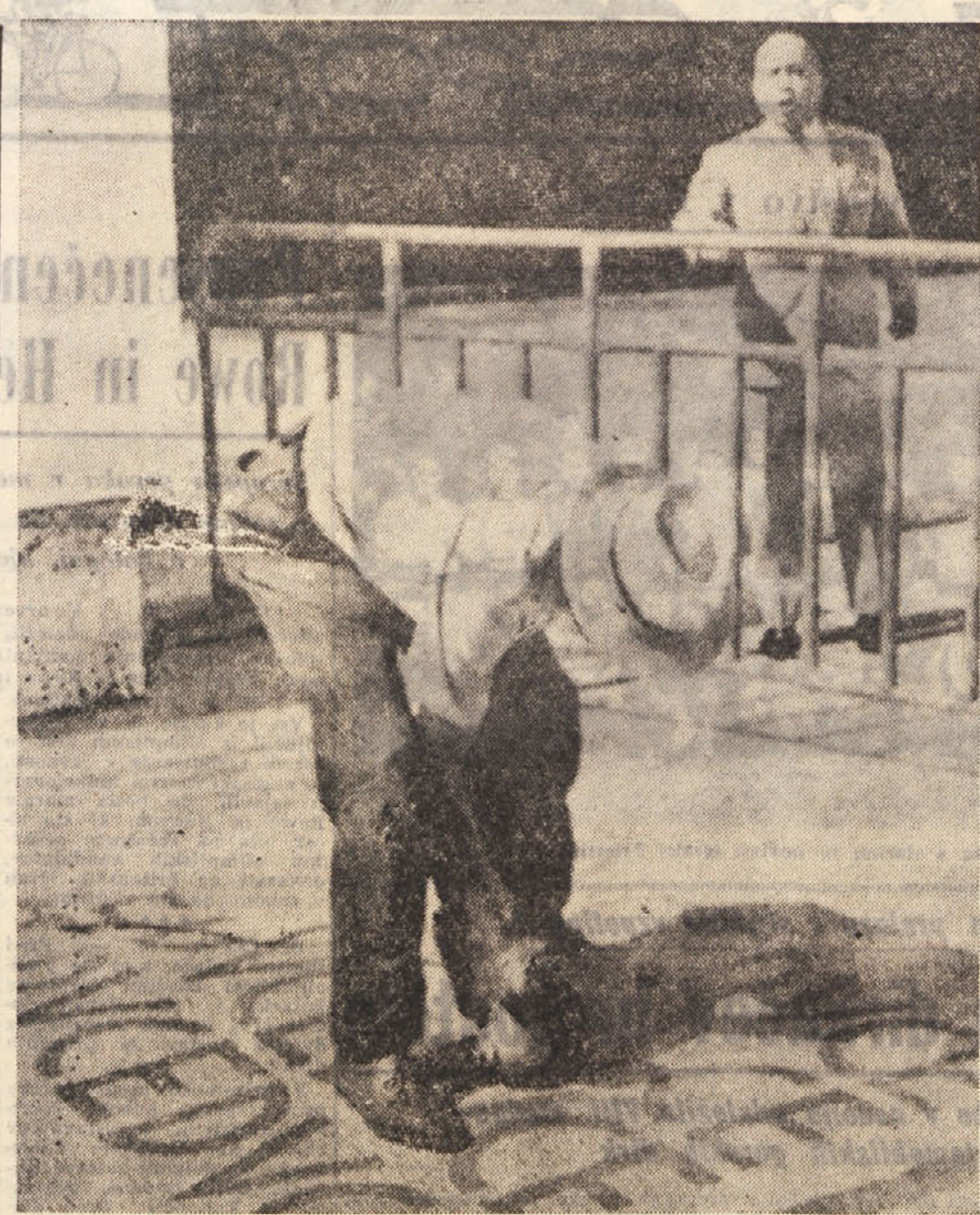
Delavec s posebno žago reže mozaik na olimpijski cesti, kjer ne manjka fašističnih napisov
