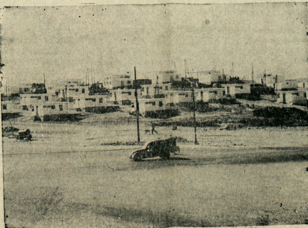
OBNOVA NAPREDUJE — Lani je hud potres skoro popolnoma uničil maroško letoviško mesto Agadir. Mesto so začeli obnavljati. Na sliki vidimo skupino tovarniško izdelanih hišic, ki jih postavljajo na mesto nekdanjih domov.
