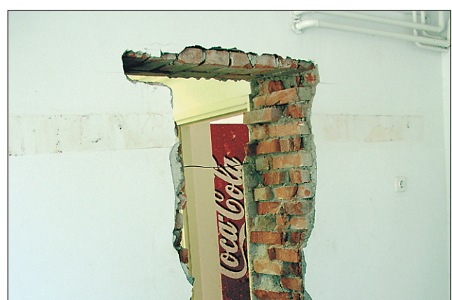
Ptujski Mestni stadion je v teh dneh pravo gradbišče.
