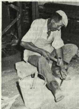
Franc Sajevec — kdo ga ne pozna, saj ima v rokah vedno »macolo in majzle«; tokrat pri popravilu tal v plemenitilnici
