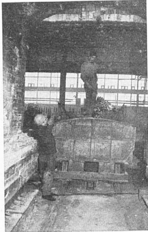
Pri večjih remontnih delih je treba posebej paziti na osebno varnost. Premik voza pri žarilni peči je povzročil remontnemu delavcu tov. Klančniku težjo telesno poškodbo, ko ga je stisnil v profilu k steni peči
