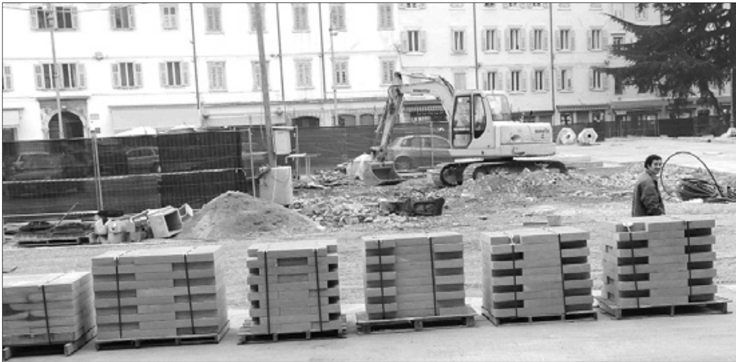
Gradbišče na Travniku s kamnom, ki ga bodo uporabili za tlakovanje
