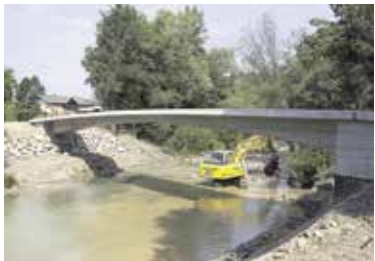
Gradnja Mlinarske brvi v Radomljah
