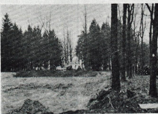
Gradnja se je že začela.
