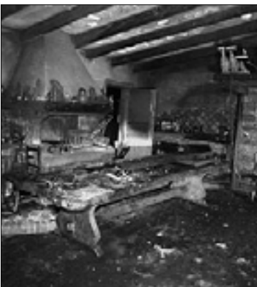
Škoda po požaru
