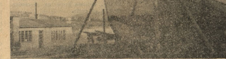
NEI CANTIERI PIRANESI
