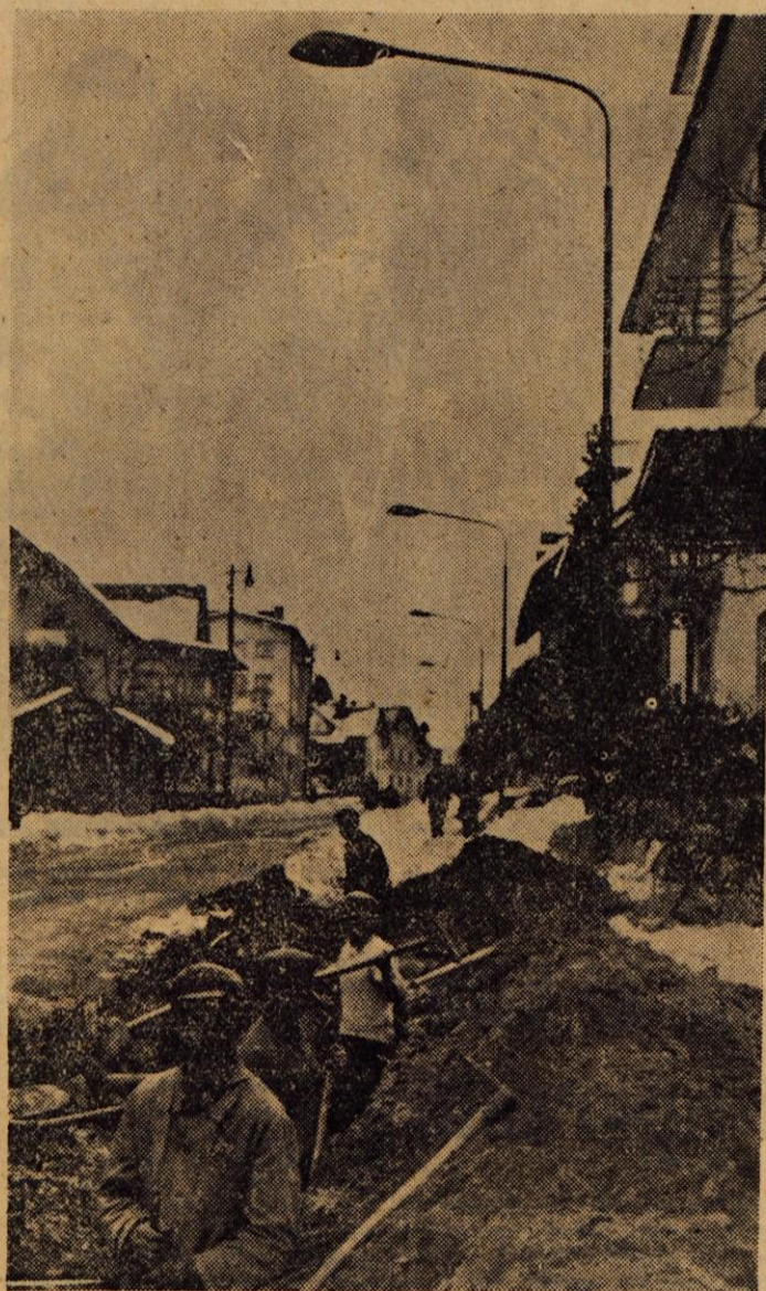
Ob glavni cesti skozi Bled so že postavili nove drogove s svetilkami. Te dni kopljejo kanale za električno kablovsko napeljavo, in če ne bo večjih vremenskih nepravilnosti, bodo nove svetilke kmalu zažarele.
