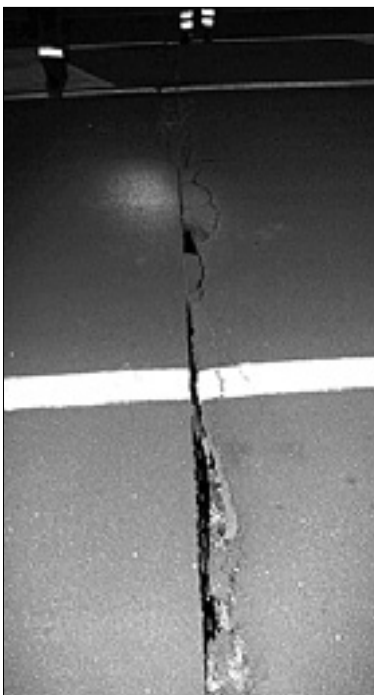
Razpoka skozi vso širino mosta (levo) in luknja v asfaltu (desno)
