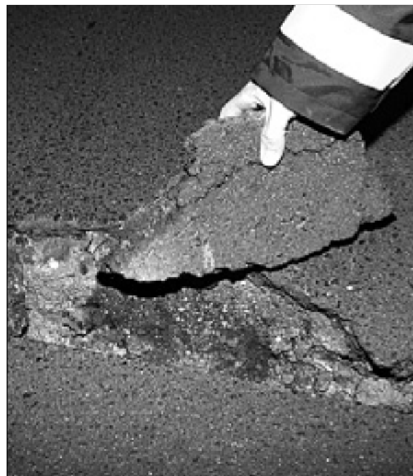
Razpoka skozi vso širino mosta (levo) in luknja v asfaltu (desno)
