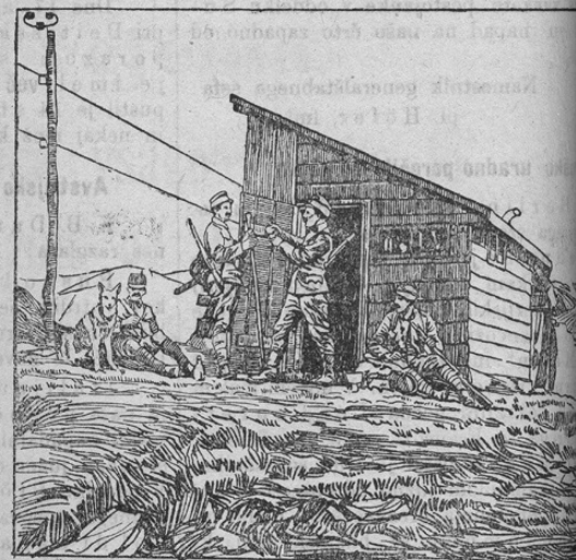
Eine Telefonzentrale in 3500m Höhe.
