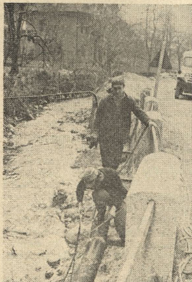
Varenje jeklenih cevi
