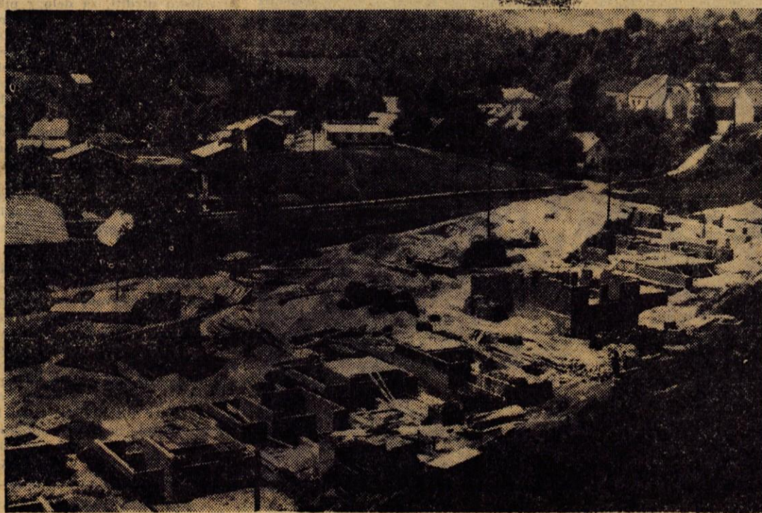
Stružvo pri Kranju se naglo razvija. Tudi letos je v gradnji več stanovanjskih hiš. Nekaj jih gradijo posamezniki sami, nekateri pa so zastavili z združno gradnjo (na sliki)
