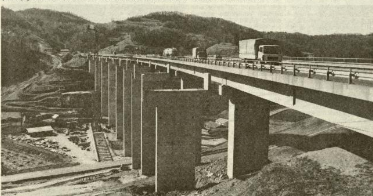
Nosilci za novo cesto so že postavljeni, predor Pletovarje pa naj bi izvrtali do aprila.
